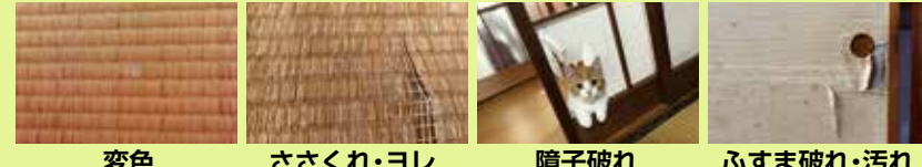
変色 ささくれ・ヨレ 障子破れ ふすま破れ・汚れ
